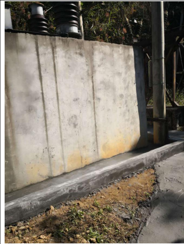
变压器围堰
