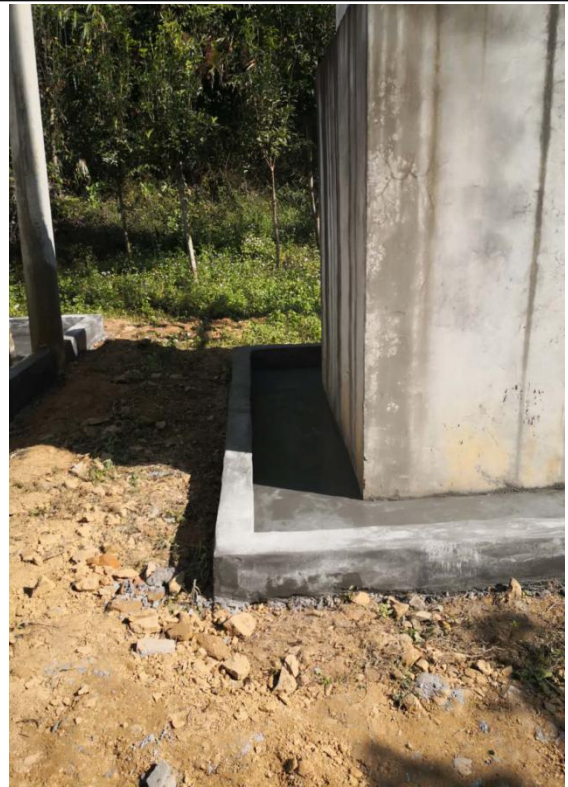
变压器围堰
